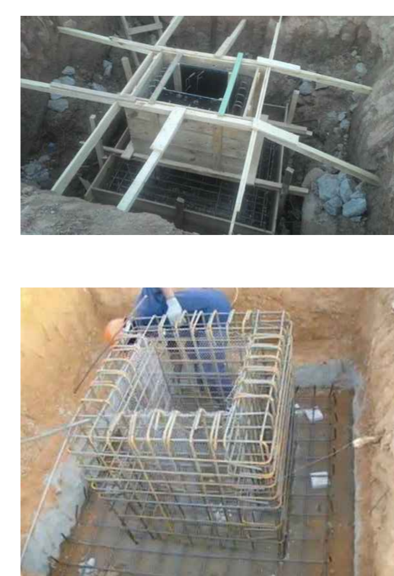
ARMADURA E CAIXARIA TAÇAS SEM ESCALA
