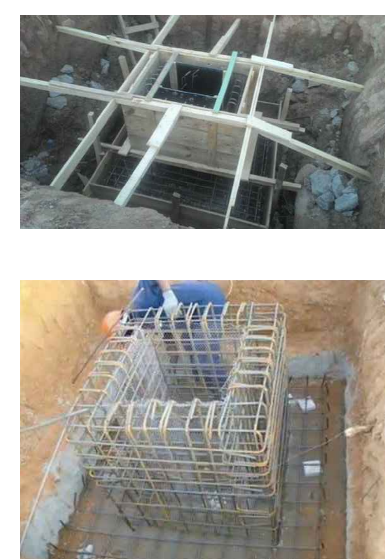
ARMADURA E CAIXARIA TAÇAS SEM ESCALA
