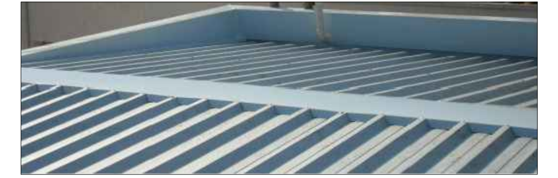
DETALHE TELHA TRAPEZOIDAL TIPO SANDUÍCHE (3 CAMADAS)
