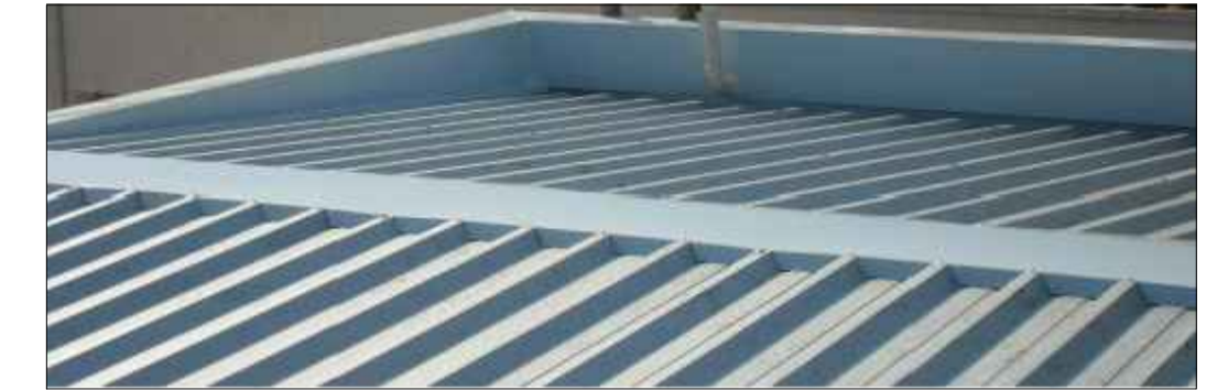
DETALHE TELHA TRAPEZOIDAL TIPO SANDUÍCHE (3 CAMADAS)
